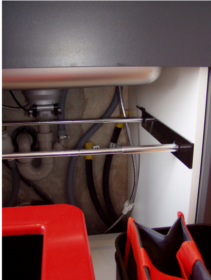
Anlage im Keller montiert.
